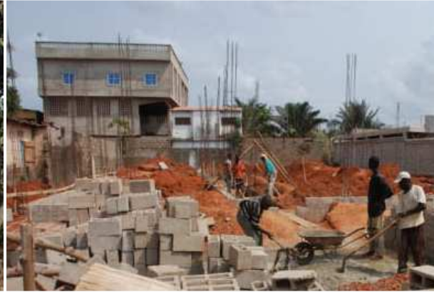
Un chantier très prometteur : le futur centre de ESPOIR VIE TOGO
